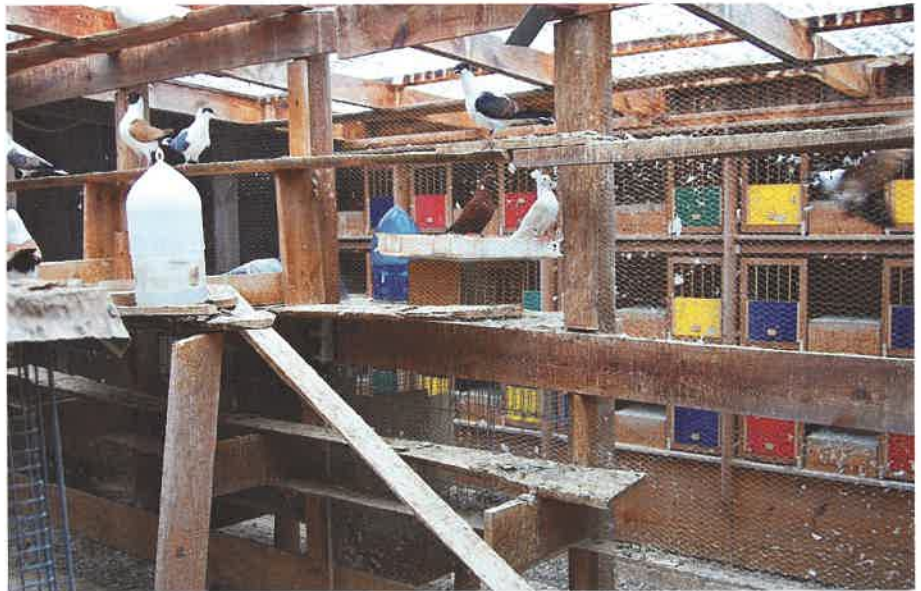
Taubenschlag auf dem Dachboden über dem Schafstall
